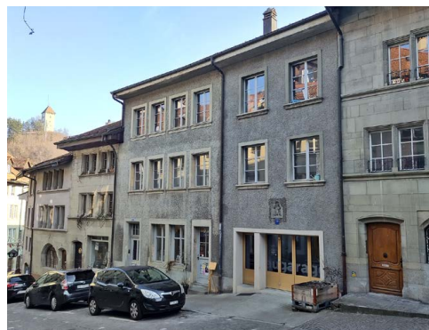
Coopérative d'habitation du quartier de l'Auge, rue de la Samaritaine, Fribourg
